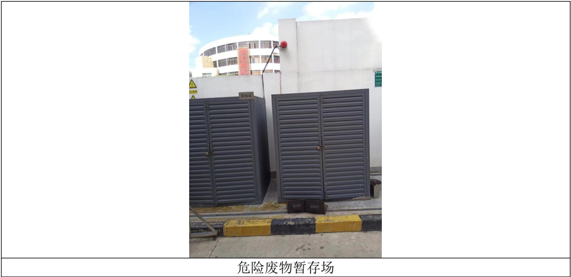
图 4.1-6 固体废物暂存场所现场照片
