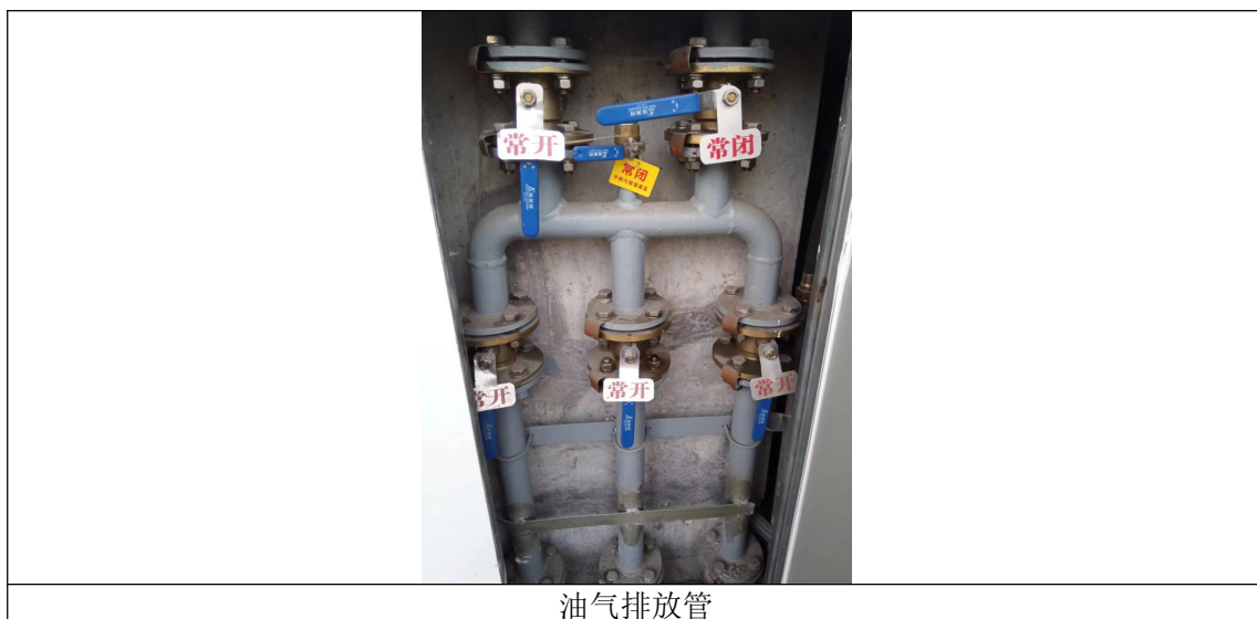
图 4.1-5 废气治理设施现场照片
